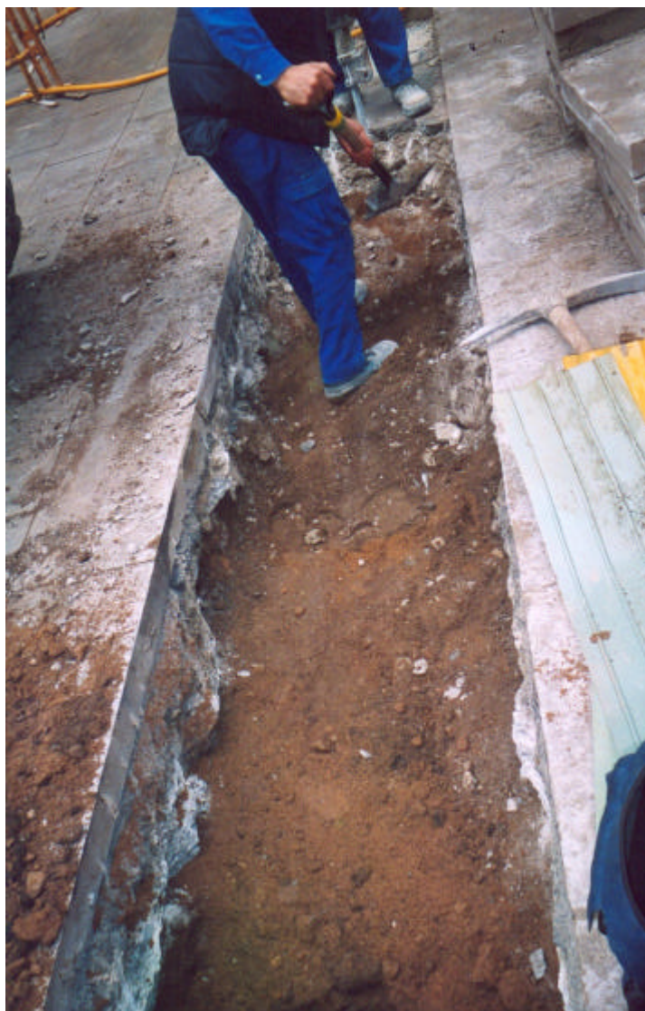
Foto. 1: Detall dels treballs d' obertura de la rasa 1000.
