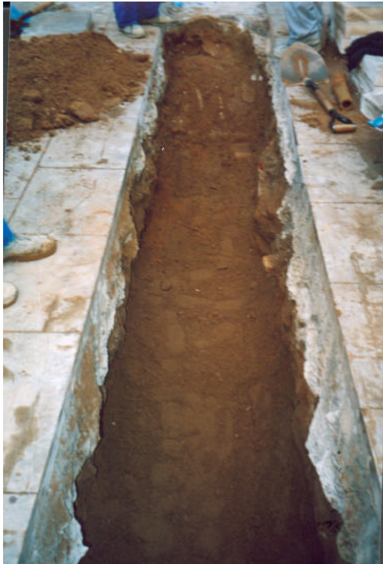
Foto 2: Detall de la rasa 1000 un cop tret el paviment.
